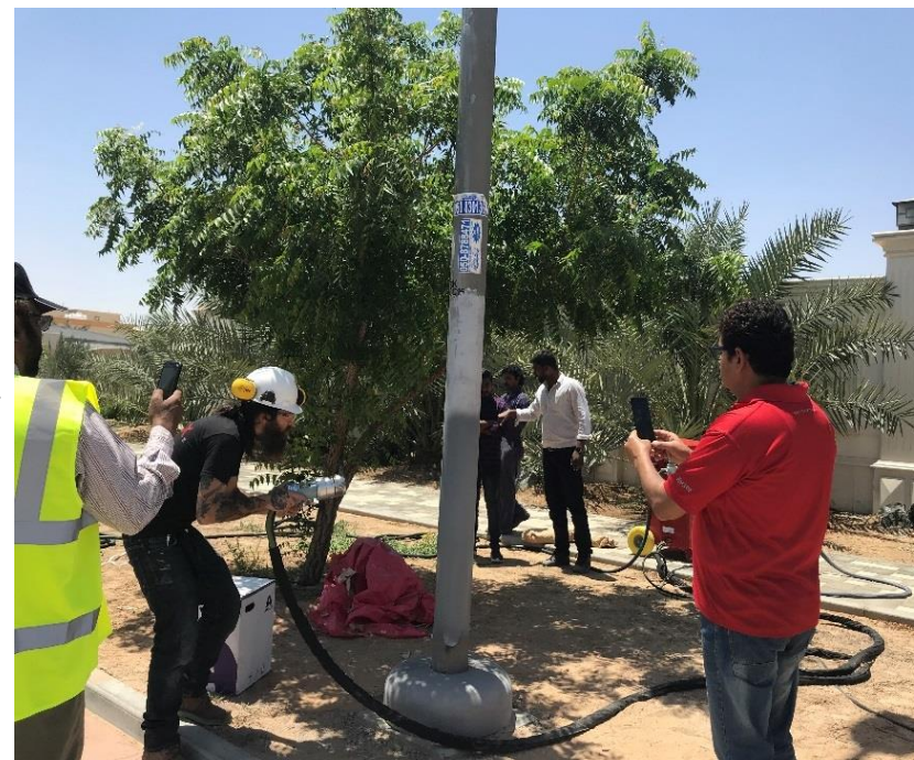
Rivestimento con PHC, Flame Spray
