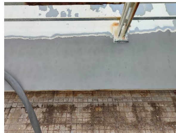
Superficie sabbata con IBIX 60 HI PRO e compressore di Metal wood da 8000 litri
