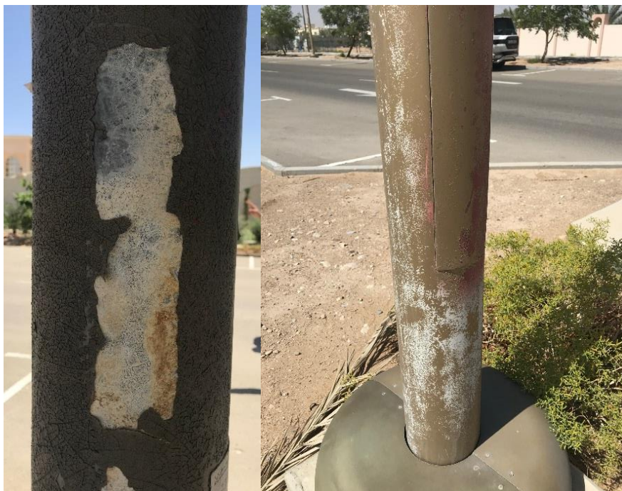
Verniciatura a base di rivestimento termoindurente
